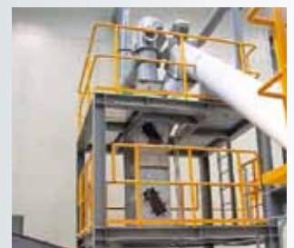
Zick-Zack-Sichter-Einheit mit Fördertechnik und Stahlbau
